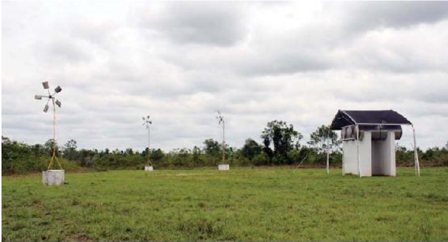
Bombas de agua de molinos de viento para Los tanques de almacenamiento de donde Se lleva el agua a la planta de purificación y embotellamiento
