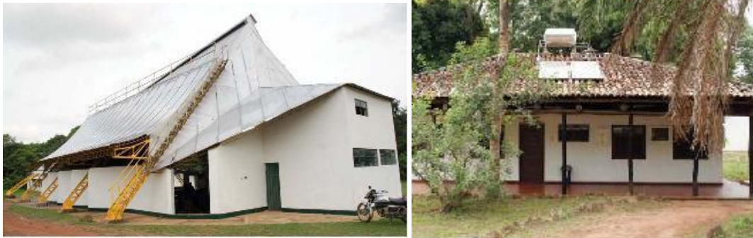
El salón de reuniones de los gavioteros (izquierda) y la casa de estilo tradicional, (derecha) están contruidos con ladrillos de cemento de tierra prensados a mano
